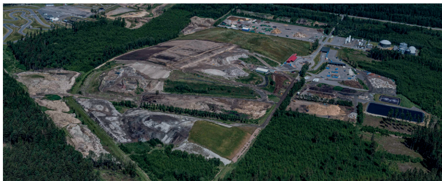
Fig. 20 Avfallsanläggningen i förgrunden, biogasanläggningen i ö h, juni 2018
